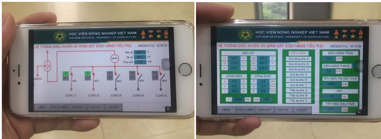
Hình 13. Giao diện điều khiển, giám sát phụ tải điện từ xa trên hệ thống
